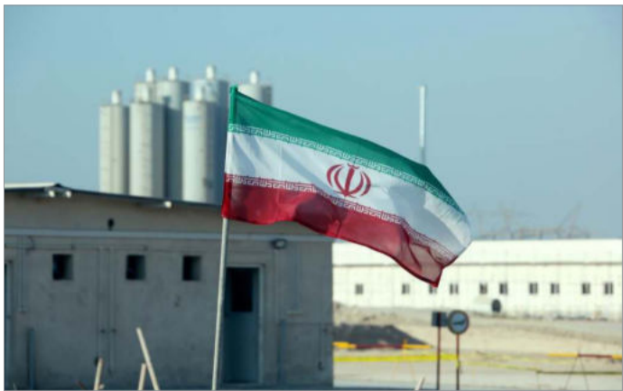
نیروگاه اتمی بوشهر
