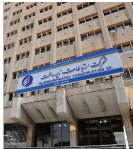
ساختمان مرکزی شرکت ارتباطات زیرساخت در تهران
