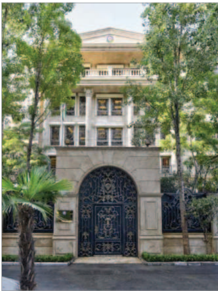
ساختمان جدید سفارت جمهوری آذربایجان در خیابان «دروس»
