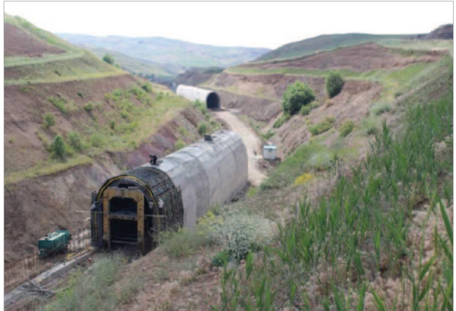
پروژه نیمه کار راه آهن شمال- جنوب
